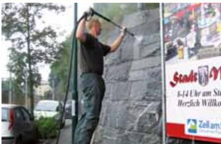
Entfernen der gelösten Verschmutzung mittels Wasser (druckunterstützt). Absaugen/Entsorgen des Schmutzwassers.
