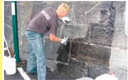
Auftragen von Cleanexan von unten nach oben mittel Bürste od. Airless (pur)
